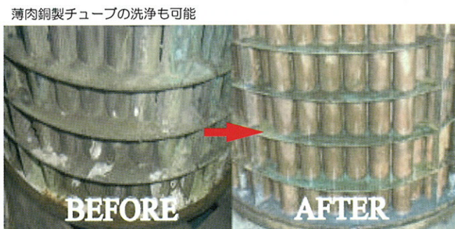
内径800mm、全長5mの熱交換器 処理時間は、最大で5時間以内(従来製品では8時間-12時間以上)
